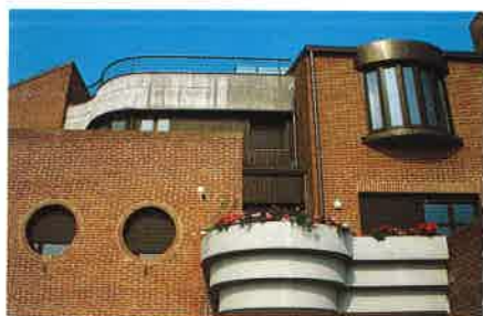
Figg. 604-605. Prospetto e visione di dettaglio del fronte prospiciente il viale di accesso.
